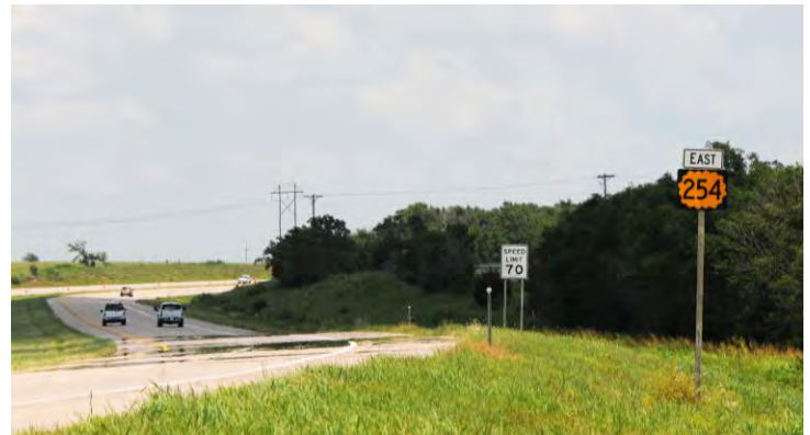
El tráfico en dirección este circula por la ruta K-254, un corredor clave que se está evaluando para mejoras en las intersecciones.
